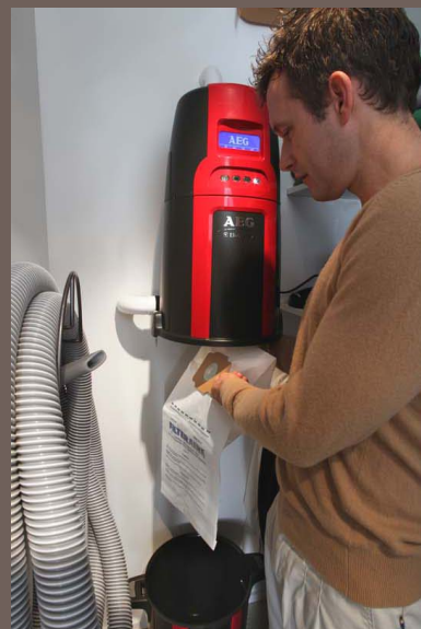
Zdjęcie przedstawia montaż opcjonalnego jednorazowego worka papierowego w zbiorniku na śmieci jednostki centralnej AEG Oxygen 870
